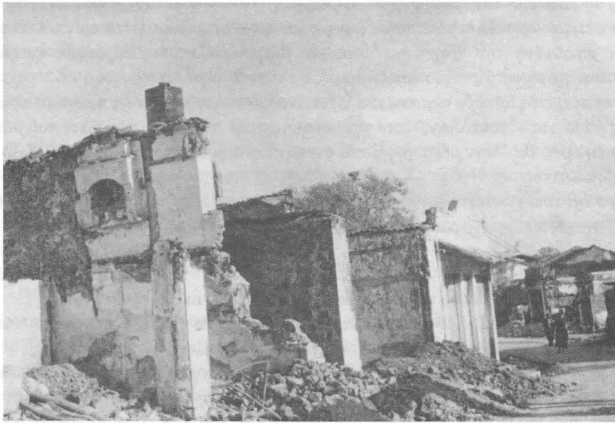
Εικόνα 45. Καταστροφές στη Χρυσούπολη Καβάλας
