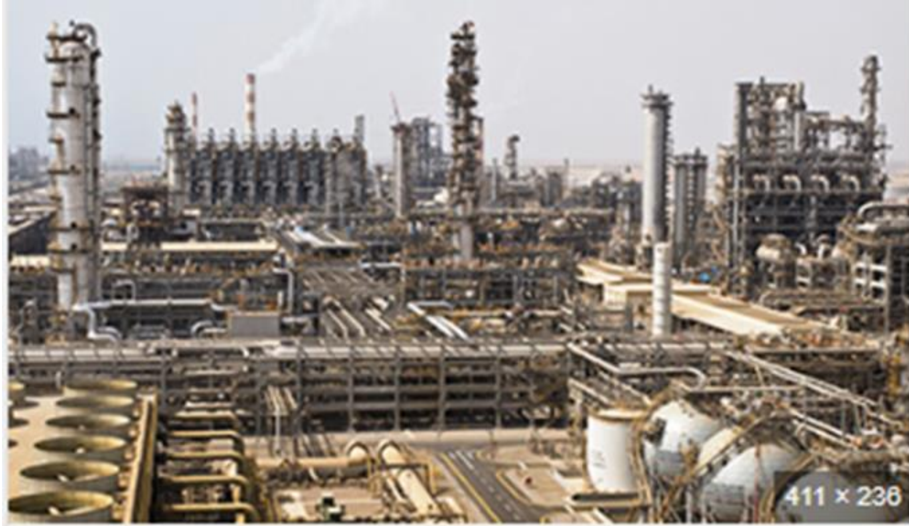
Εικόνα 22. Μονάδα μετατροπής φυσικού αερίου σε πολυαιθυλένιο, πιθανόν στην Παλαιόχωρα. Αυτή η μετατροπή ανοίγει τον δρόμο να γίνει η νότια Κρήτη βάση της ανάπτυξης της χημικής βιομηχανίας στο νησί
